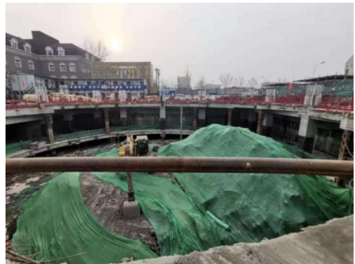
(2) 现场施工照片
