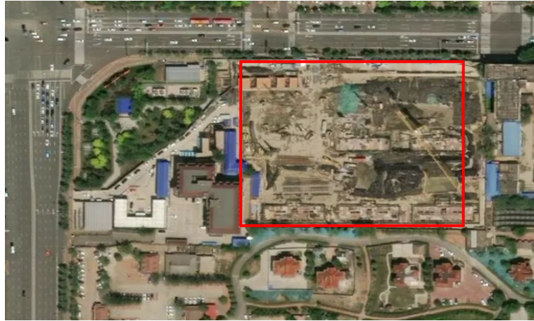
图 25 南开区某房地产施工区域
