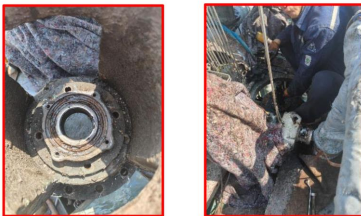
图 2.2-5 滤料搅拌机维修
