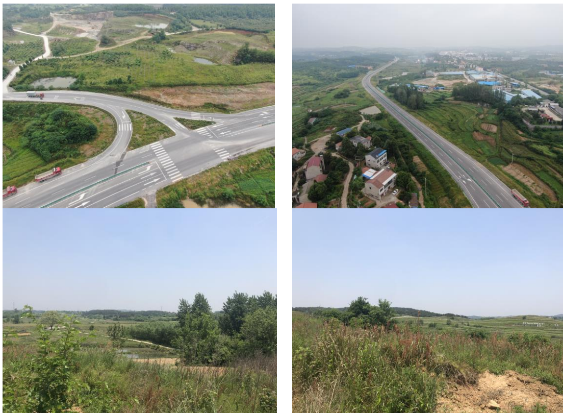
图 4-1 变动段线路沿线环境现状
