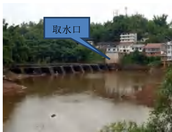
黄沙河取水口现状
