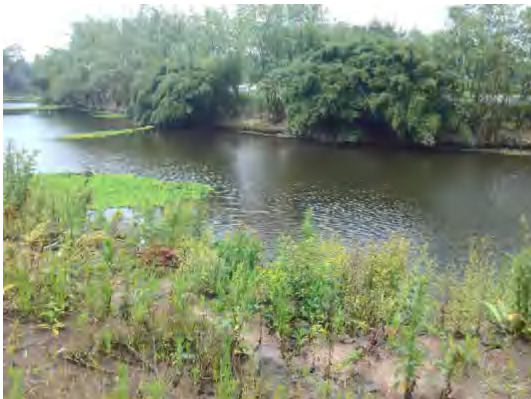
龙溪河双线特大桥桥址现状
