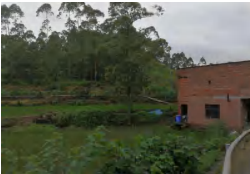
图 8.1-1 (b2) 友胜村牵引变电所选址实景图
