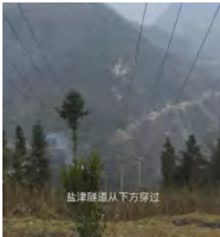
盐津隧道从地表下穿过
