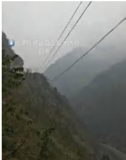
三股水大桥桥头接盐津隧道位置
