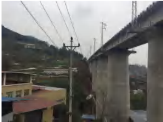
皮匠沟特大桥
