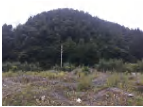
彭家隧道出口
