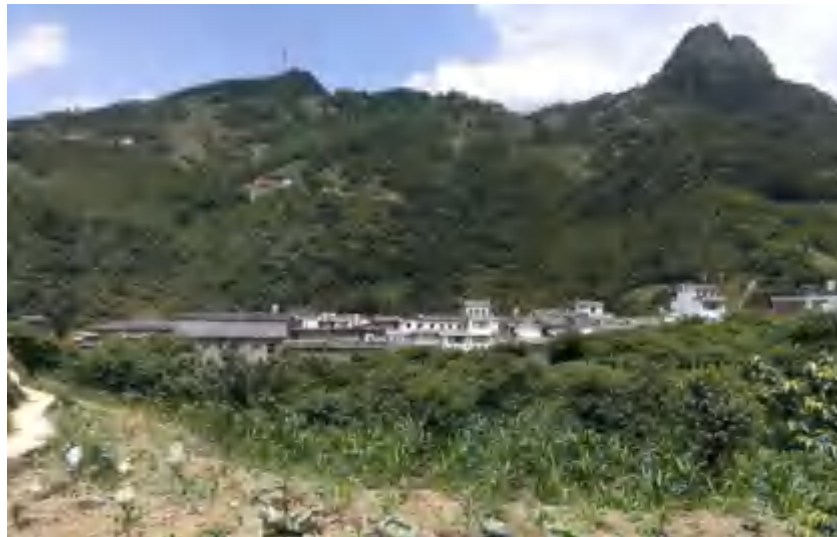
图 8.1-1 (f2) 盐津南牵引变电所选址实景图
