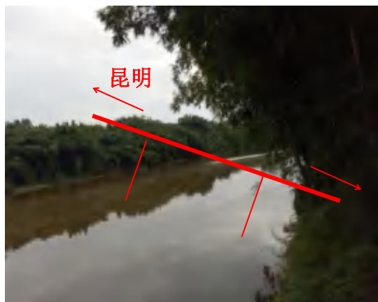
工程跨越黄沙河现状
