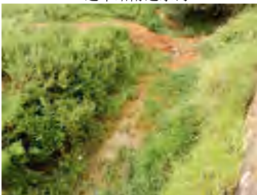
长水机场站附近水沟
