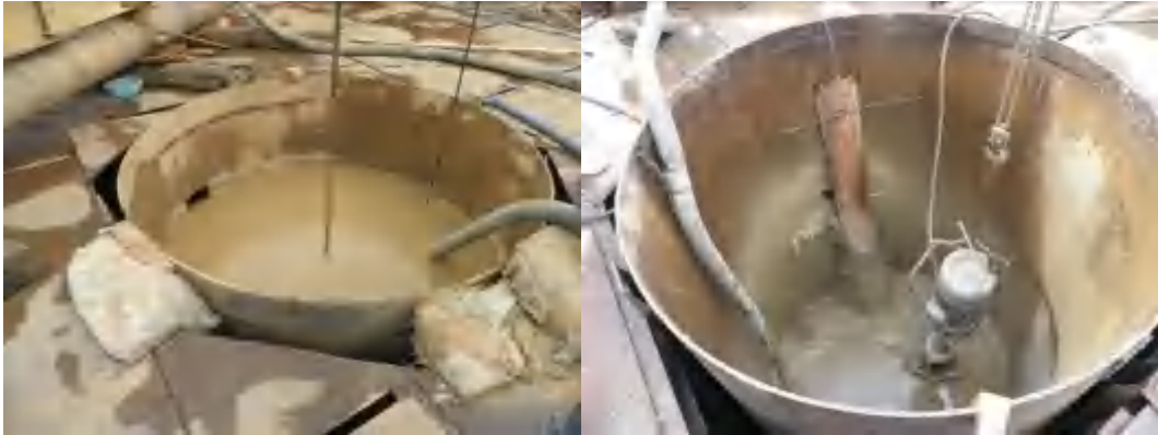
桥梁钢围堰施工
