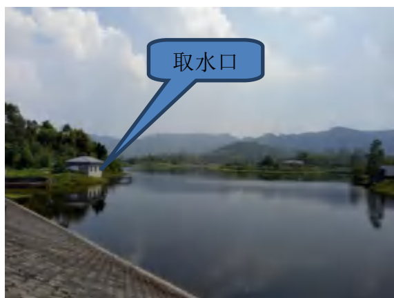
杨家桥水库取水口
