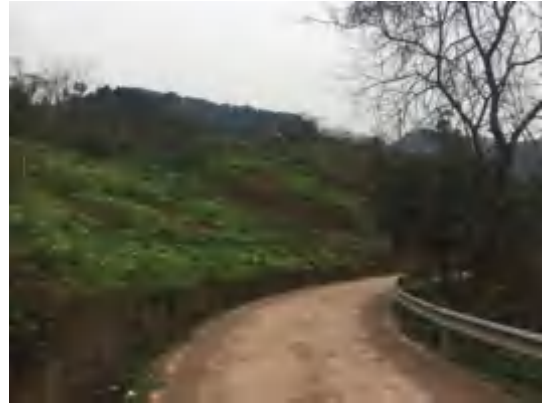
新桥村隧道进口
