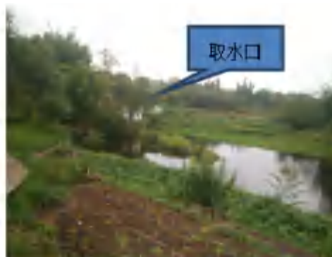
观音桥水库取水口现状
