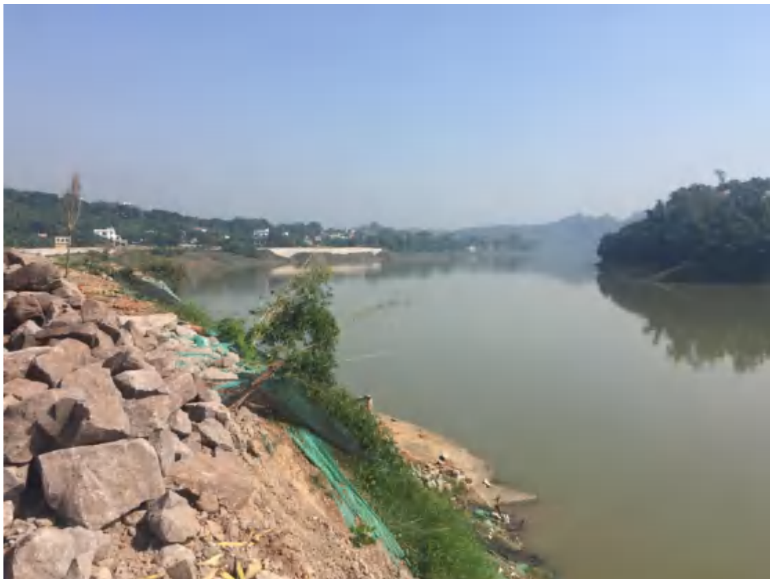
沱江双线特大桥桥址现状
