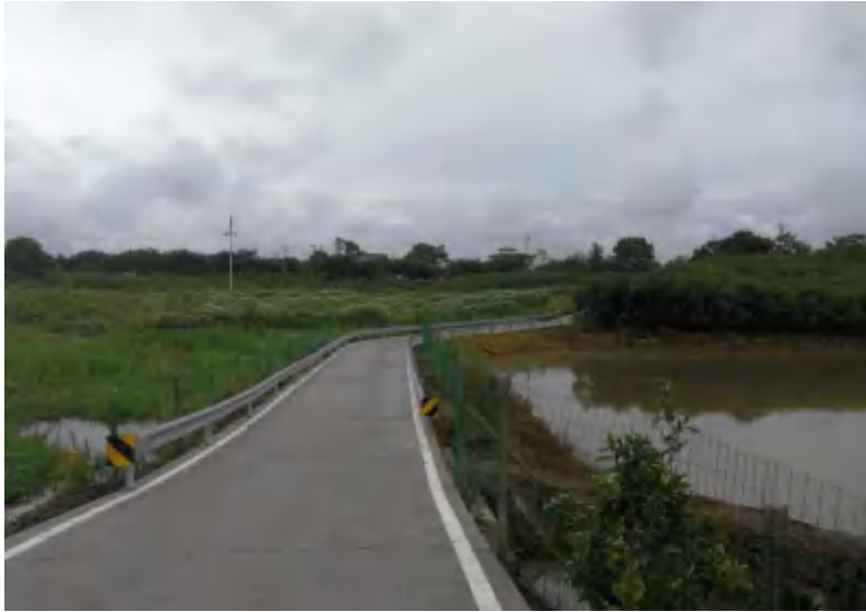
图 8.1-1 (a2) 江津北牵引变电所选址实景图
